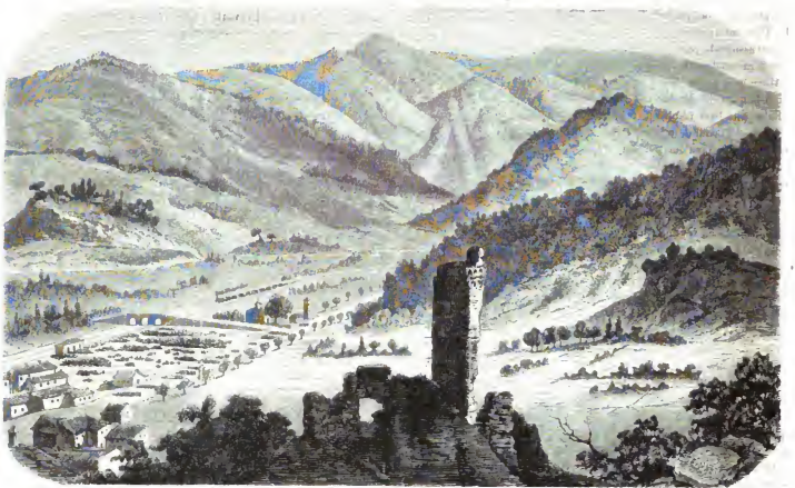
VALLEE DE LA SURVIA, DE RIGOBOSO A ARQUATA.
